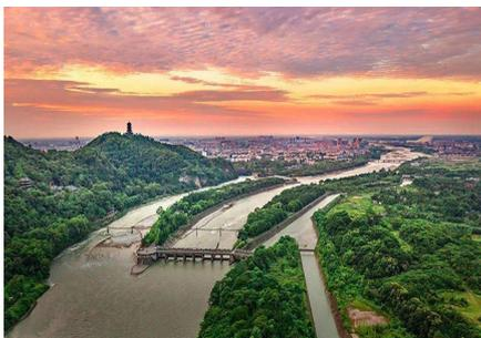
**【都江堰水利工程】**位於都江堰市城西岷江幹流上，由秦國蜀郡太守李冰及其子率眾於西元前 256 年左右修建，是全世界迄今為止，年代最久、唯一留存、以無壩引水為特徵的宏大水利工程，也是目前中國保存最完整的古代水利工程。工程由魚嘴分水堤、飛沙堰溢洪道、寶瓶口引水口三大主體工程和百丈堤、人字堤等附屬工程構成，把洶湧的岷江分隔成外江和內江，外江排洪，內江引水灌溉，使川西平原成為「水旱從人」的「天府之國」。兩千多年來，一直發揮著防洪灌溉作用，澤被至
